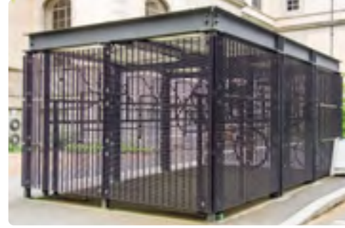
Kapılar ve dış mekan konteynerleri
