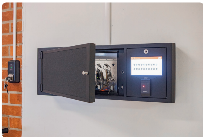
I Trakaskåpet hämtar entreprenören ut en CLIQ-nyckel och laddar den med rätt behörighet.
