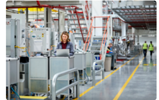
Máquinas e painéis de controlo
