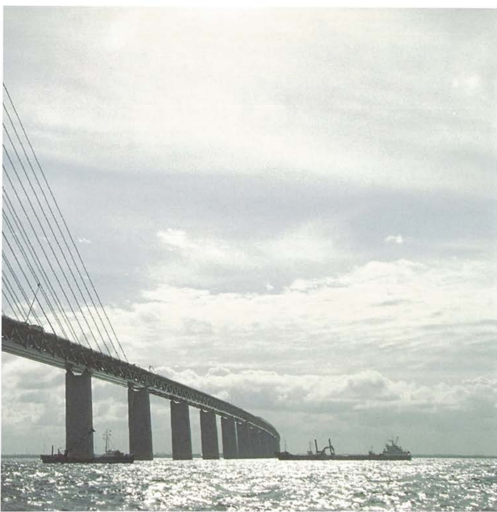
Öresundsbron, den nya länken mellan Danmark och Sverige, har utrustats med Combi Plus lås och motorlås från Ruko samt lås från svenska Assa. Dessutom har man valt att installera FUNXION-dörrhandtag, som är extremt vädertåligen.
