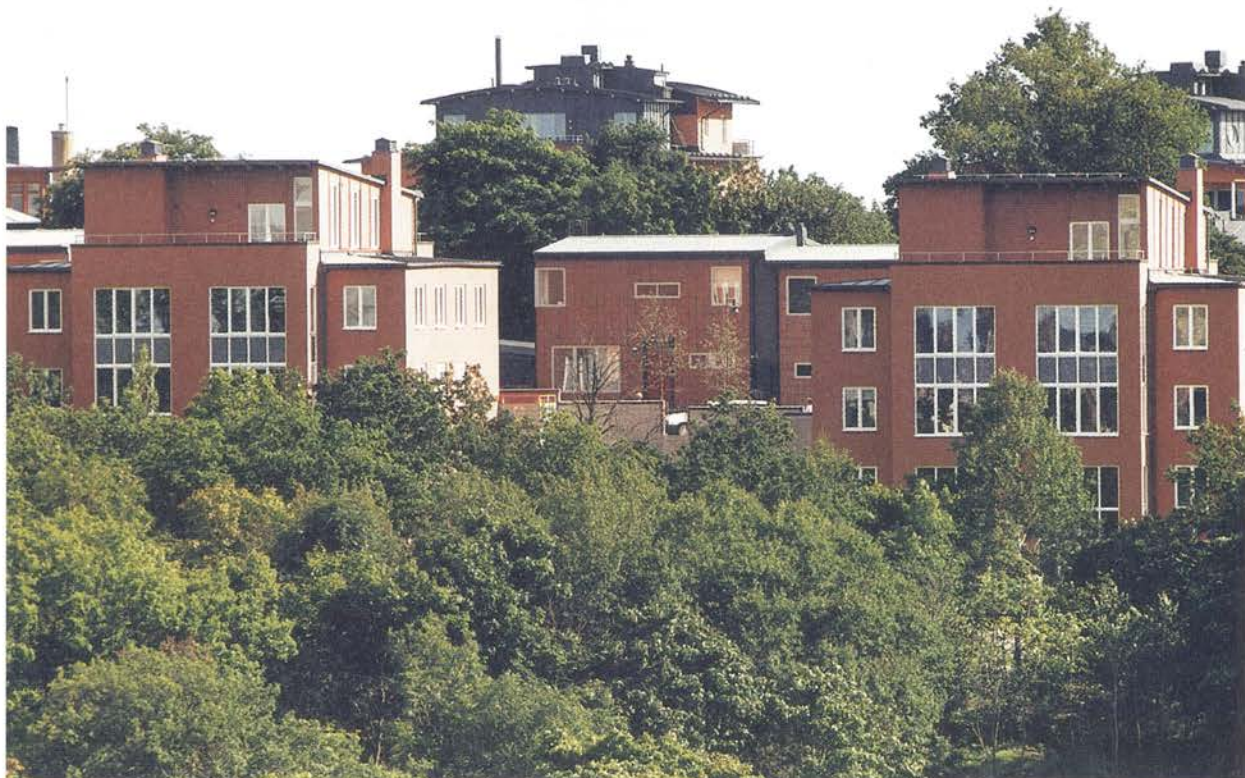
Assa levererar helt nickelfria produkter för dörrsäkerhet, och byggföretaget Skanska använde nyligen dessa vid uppförandet av nya allergivänliga hus i Sverige.
