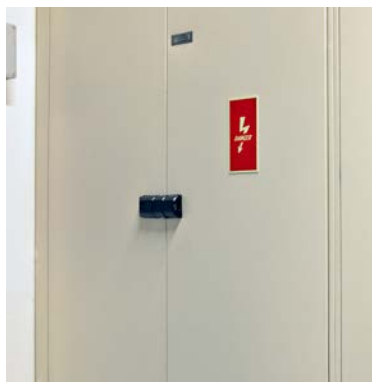
Zajištění elektrorozvodů zámkem MVP2000
