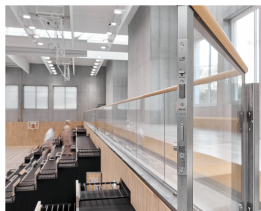
Für ein hohes Mass an Sicherheit in der Primarschule sorgen unter anderem die eingebauten MSL DELTA und FlipLock Schlösser.
