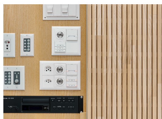
In das Steuerungstableau für das Licht und die Trennvorhänge in der Sporthalle sind Schaltzylinder von KESO eCLIQ verbaut.
